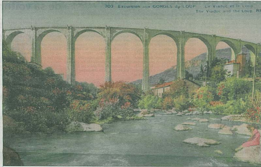
L'imposant viaduc du Pont-du-Loup, 11 arches de 20 mètres, au temps de la splendeur de la ligne. (Collection privée)
